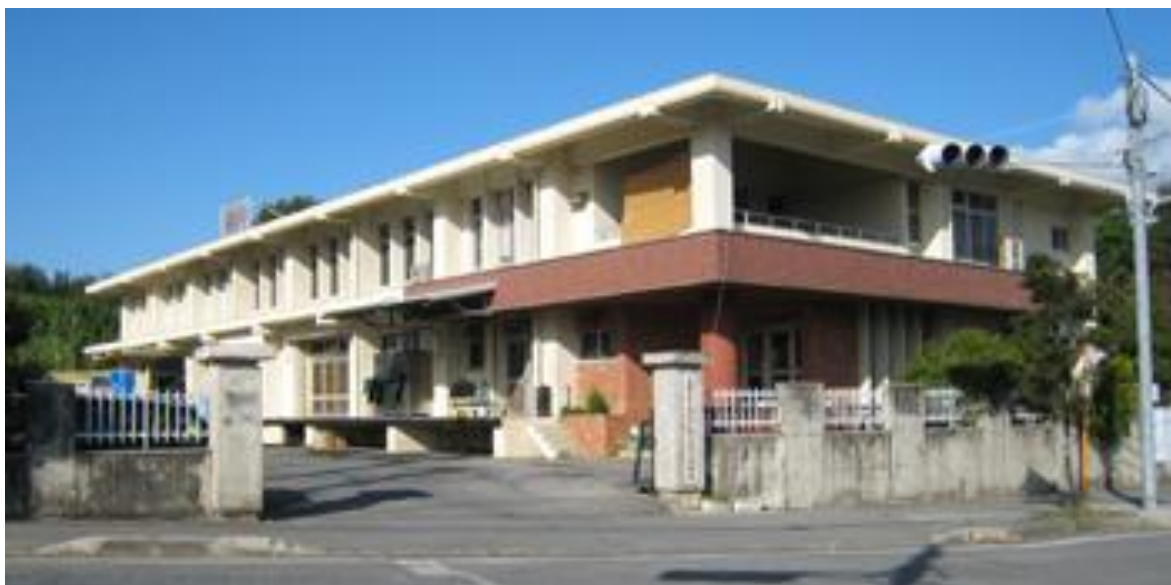
図2-1 現給食センター外観写真
