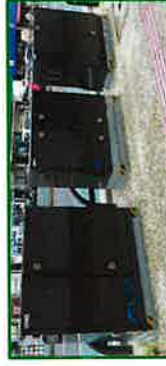
画像：電線共同溝方式による無電柱化 宜野湾市内設置 地上機器
