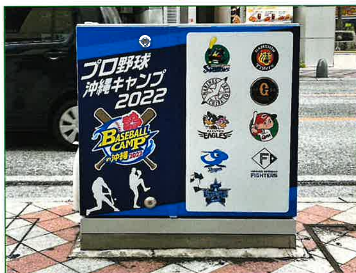
例：地上機器ラッピング施工後
