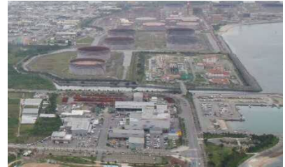
西原船だまり・ 沖縄県西原浄化センター
