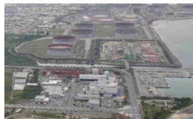
西原船だまり・ 沖縄県西原浄化センター
