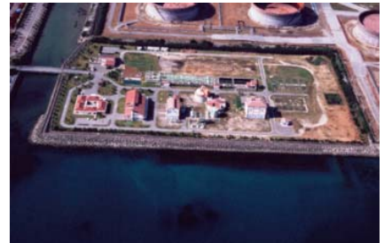
沖縄県西原浄化センター
