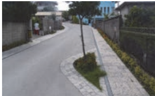
歩道と車道を識別させた例
