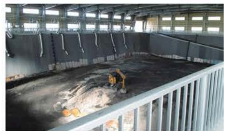
新しくつくられた最終処分場 「美らグリーン南城」
