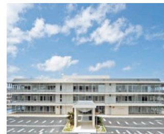
西原町役場(庁舎の一部)
