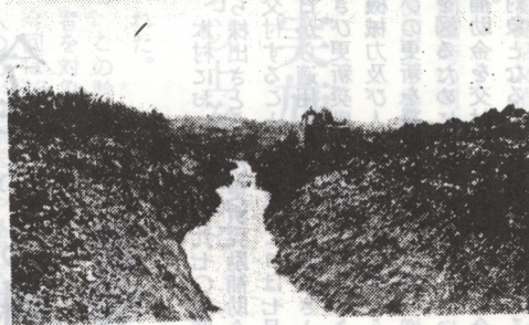
旧排水の浚渫工事
