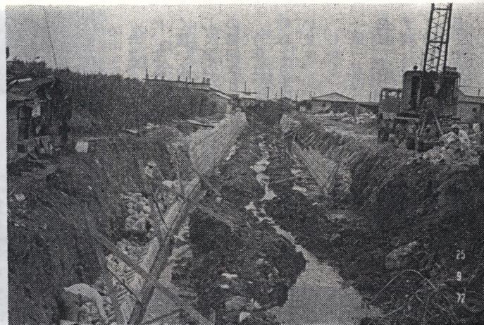
中部製糖横、河流改修工事
