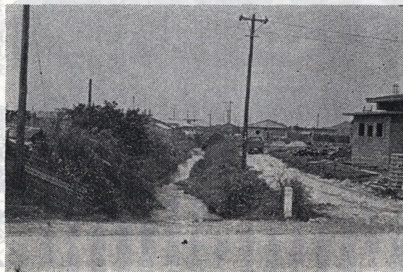
同場所、改修工事前
