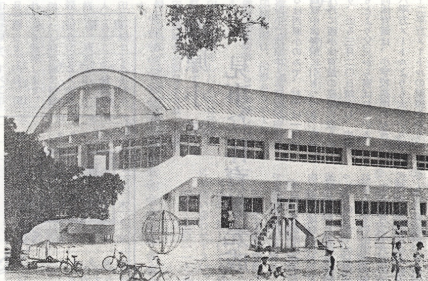
完成した、すばらしい西原小体育館
