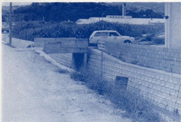
立派な排水路となり喜ばれている
