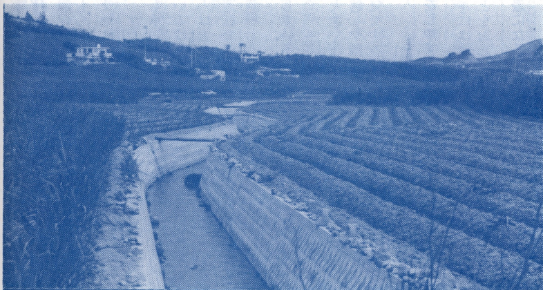
▲ 幸地川河川災害復旧工事竣工、3月26日。
