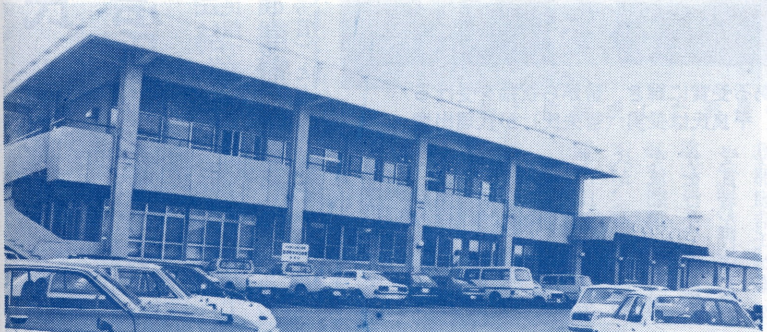
▲ 中央公民館竣工、3月31日。
