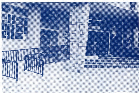
庁舎前に完成した身体障害者用スロープと自動ドア
