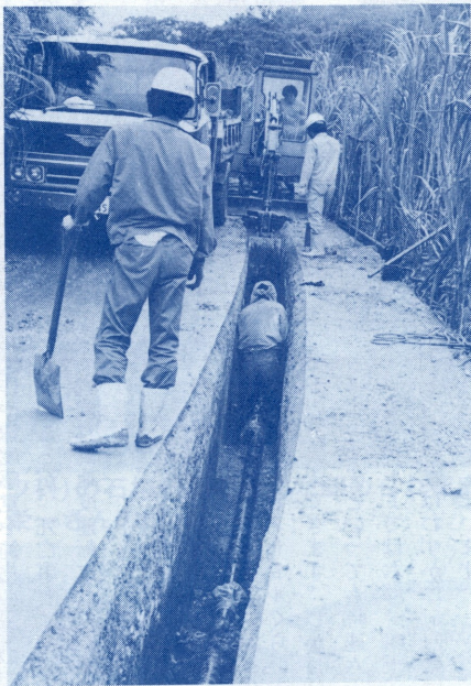
▲配水管の埋設工事 (小波津で)
