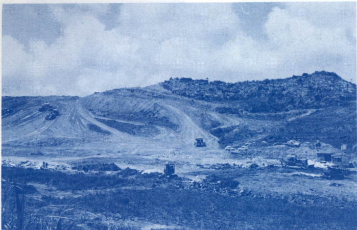
▲昭和47年、RBC坂田ハイツの造成工事。
