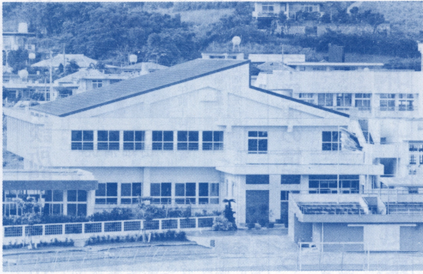
▲西原東小学校体育館新築工事・校舎新增築工事、総工費は体育館1億5,320万円、校舎1億595万円、床面積は体育館1049㎡、校舎943㎡。手前が体育館で右側校舎四階に新增築校舎ができた。普通教室4、家庭教室1、音楽教室1、準備室1。
