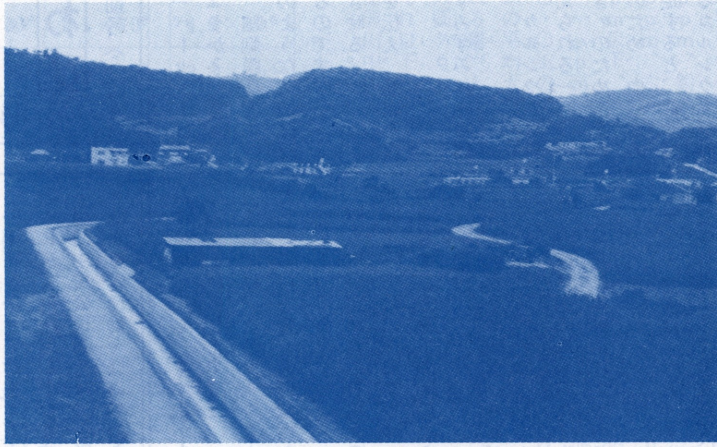
▲兼久川準用河川改修工事、総事業費4,200万円、延長276m、安室後原地内、旧更正川を約2倍に拡巾し、抜本的に排水整備。
