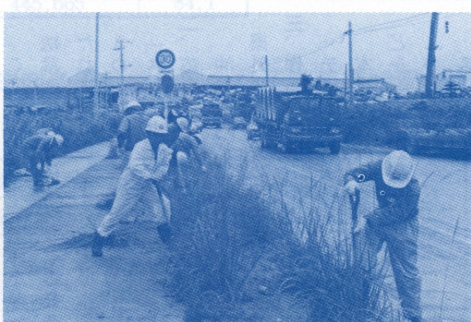
▶産業道路での作業風景
