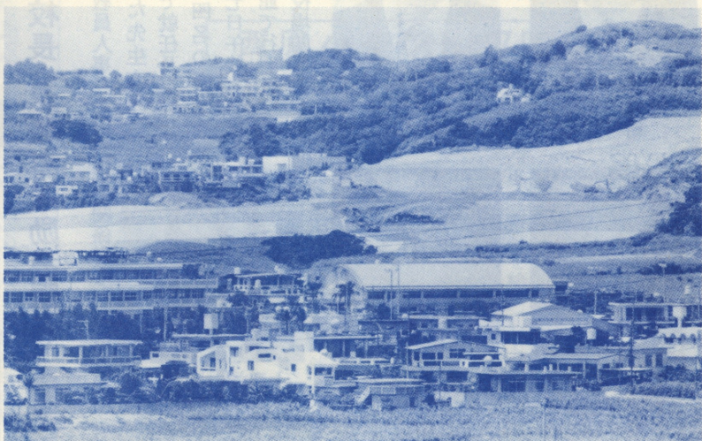
西原運動公園進入路及び体育館用地造成工事 工事費2億1,936万円、国体に向けて59年度から60年度にかけて町営体育館が建設される
