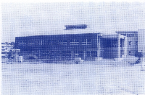
坂田小学校新体育館の全景
