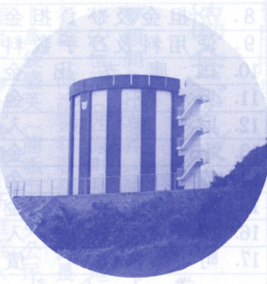
幸地池田小波津配水施設整備 事業 総事業費二億二八〇〇 万円、幸地配水池（容量一四 二〇立方メートル）建設、徳佐田 小波津団地入口の配管（延長 約六キロメートル、一〇〇～二〇〇ギ 管）布設
