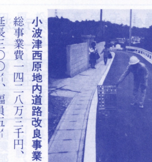
小波津西原地内道路改良事業 総事業費一四二八万三千円、 延長三〇〇メートル、幅員五
