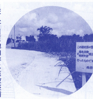
兼久古川原地内排水施設整備 事業 総事業費一四五〇万円 延長一七二メートル、幅員一
