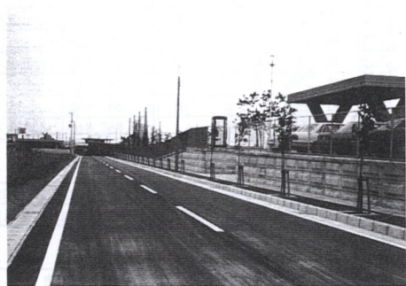
小那覇4号線道路改良工事 工事費2,325万円、延長156メートル、幅員9.5メートル
