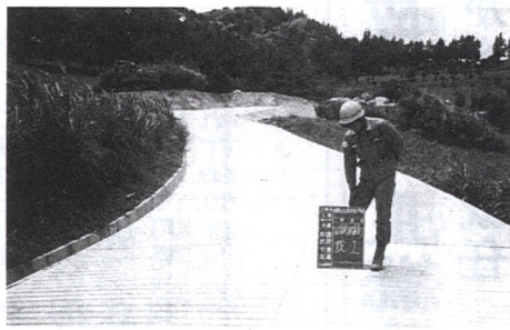
我謝地区農地保全整備工事 工事費3116万円。農道延長346メートル、幅員5メートル、排水路延長172メートル、W400×H500
