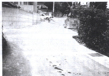
内間地内排水路整備工事 工事費870万円、延長155.6メートル、W600×H600
