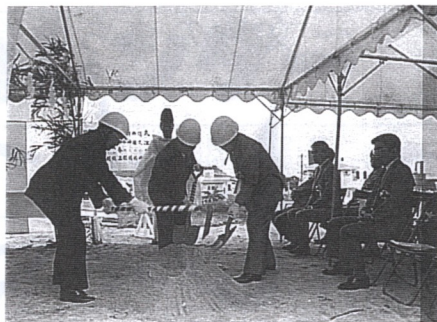
共同福祉施設の起工式 ：11月13日、字小橋川
