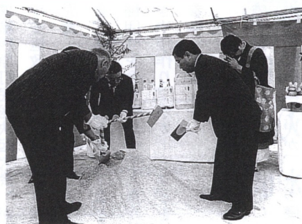
西原小分離校造成工事でクワ入れ 平成2年12月28日
