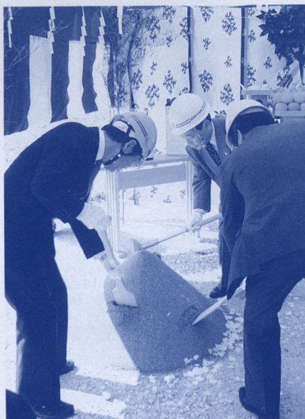
△内間配水池建設工事安全祈願祭でくわ入れの儀を行う平安町長(中央)ら
