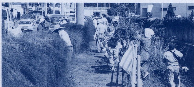
△町内主要4ヵ所で行われた清掃作業 (第15回町道路排水愛護デー)
