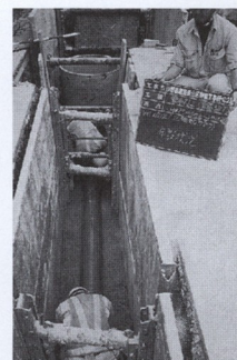
管布設工事の状況
