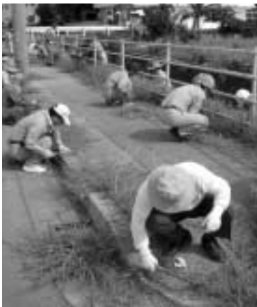
町道内間小那覇線の清掃作業の様子
