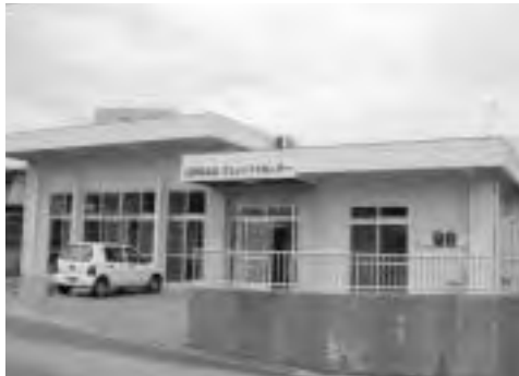
完成した上原自治会コミュニティセンター
