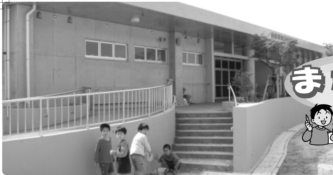
完成した西原幼稚園の新園舎
