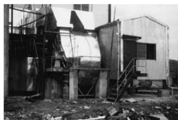
写真1 第二工場の集塵装置
