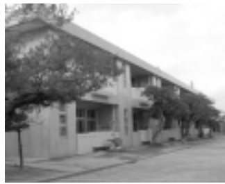
工事予定の西原小学校校舎
