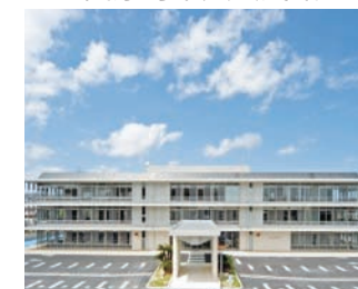
西原町役場(庁舎の一部)
