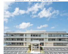
西原町役場(庁舎の一部)
