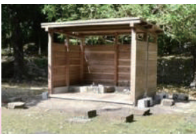
②修繕後の拝殿
