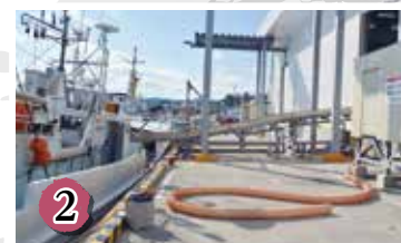
水産物荷さばき施設に着岸し、ベルトコンベアーを設置。
