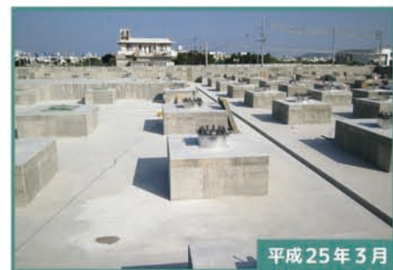
平成25年3月 この施設は防災拠点となるため、免震構造を採用しています。写真は取り付けられた免震装置で、この上部に1階部分の基礎が作られました。
