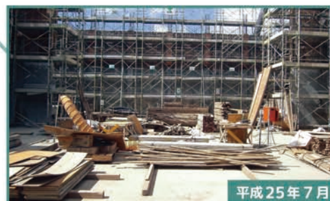
平成25年7月 この施設には、町民の文化・芸能活動の創造、発表、鑑賞の場となるさわふじ未来ホールが建てられています。写真は、建設中のホールのステージです。
