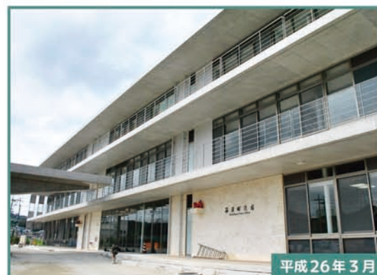
平成26年3月 完成間近の西原町役場新庁舎。間もなく全容が明らかになります！
