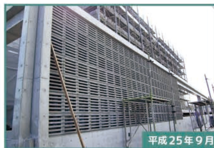
平成25年9月 壁面の一部には花ブロック（穴あきコンクリートブロック）を採用。夏場の強い日差しや視線を適度に遮り、採光や通風を確保する建材で、今回は町産の花ブロックを使っています。
