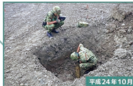
平成24年10月 磁気探査で不発弾の探査を行いました。5インチ艦砲弾1発が確認され、自衛隊の不発弾処理隊によって無事撤去されました。
