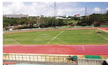
全天候型グラウンドになった陸上競技場
