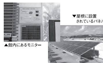
町立図書館に設置されている太陽光発電パネル(3.4キロワット)
