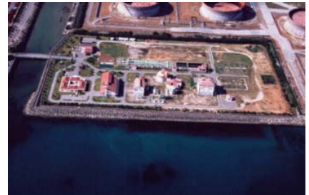
沖縄県西原浄化センター
