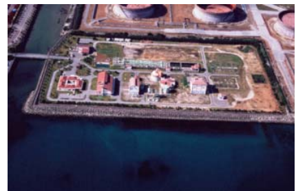
沖縄県西原浄化センター
