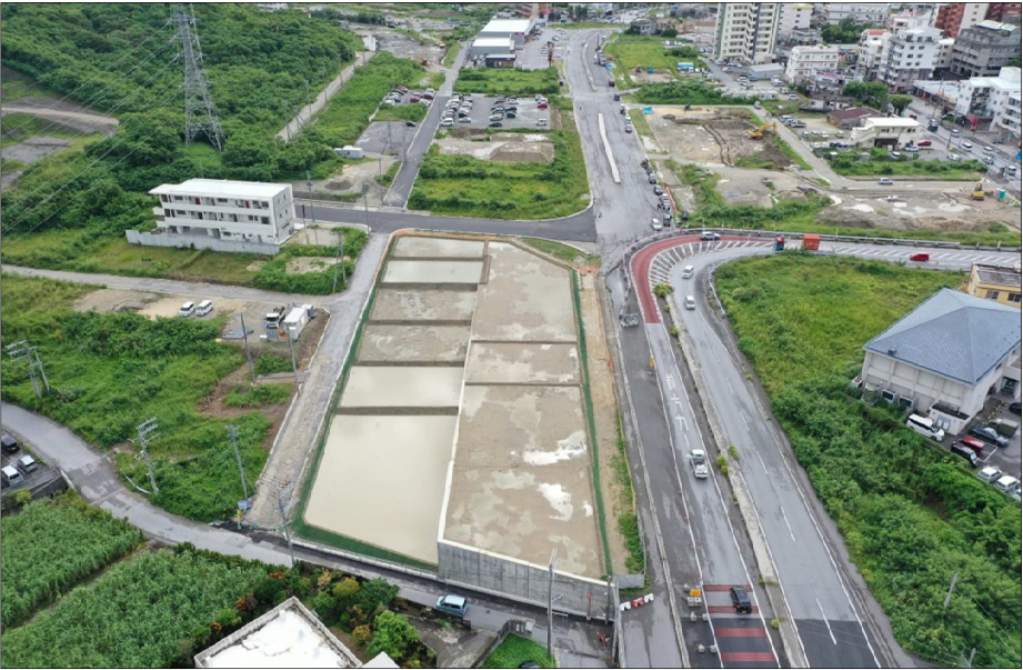
①浦添市側から東側方向整備状況(R6.10月撮影)
