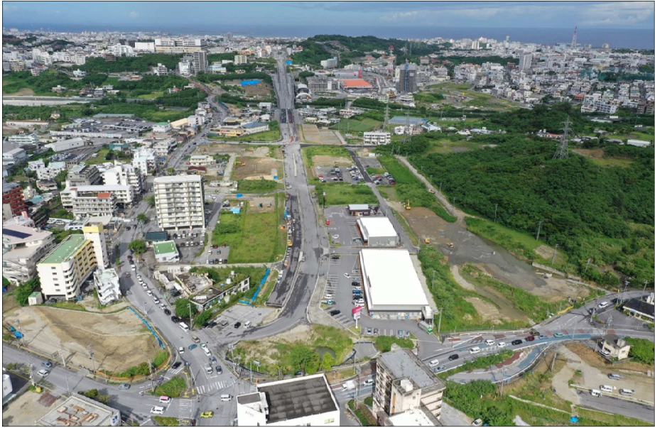
②坂田交差点側から浦添方向整備状況(R6.10月撮影)
