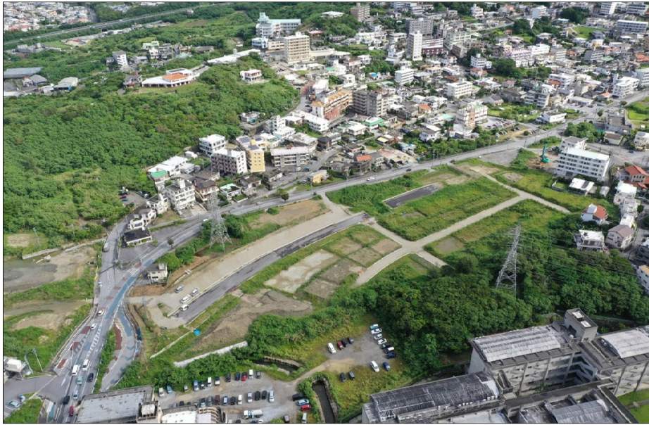
④坂田交差点側から上原方向整備状況(R6.10月撮影)
