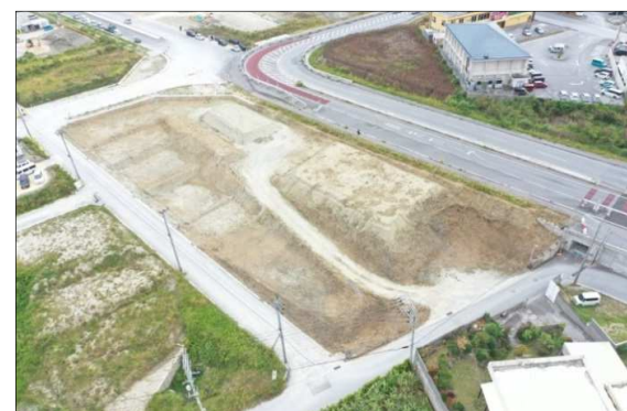
R6.1月時点（浦添西原線沿いの街区）
