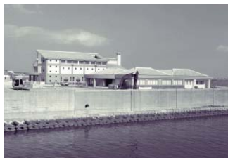
西原浄化センター
