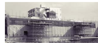
建設中の坂田保育所・児童館
