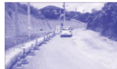
総長・上原線の継続道路工事
