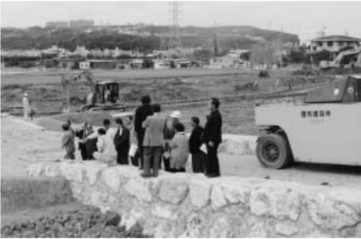
安室地区ほ場の工事現場
