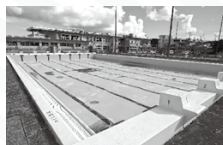
西原中学校プール
