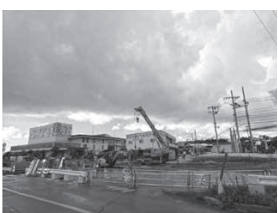
小波津川橋梁工事はどうなる？
