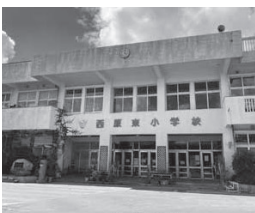
今年、建設検討委員会が立ち上がる築42年経過の西原東小学校
