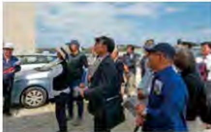
▲幸地インター線の工事進捗状況を視察（幸地地内）
