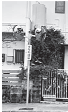
設置完了したカーブミラー
