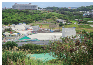
▲幸地 IC（インターチェンジ）建設工事の様子
