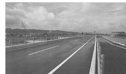
一部開通した国道329号線バイパス
