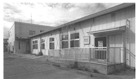
旧役場の第5庁舎(後ろは第3庁舎)
