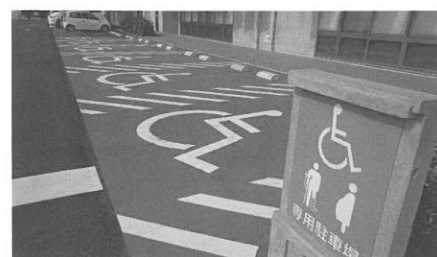
新庁舎の身障者用駐車場
